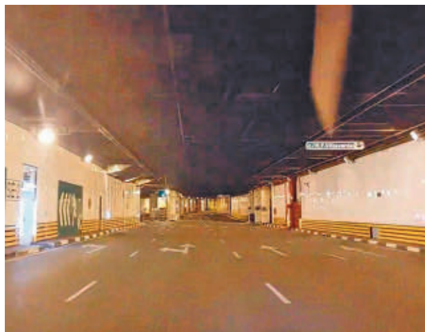
El interior del paso subterráneo
