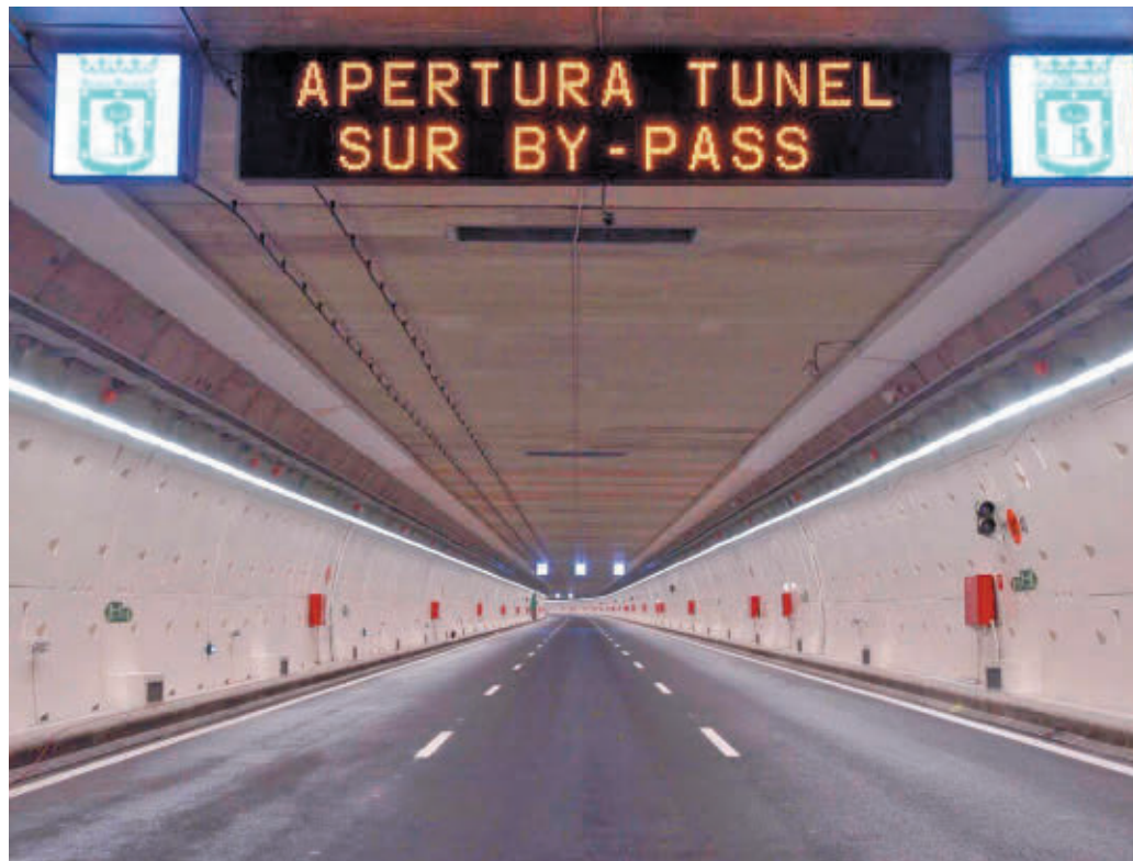
Uno de los túneles de la M-30
