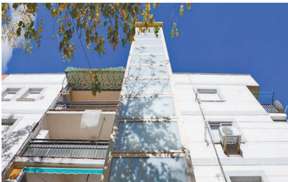
Las ayudas podrán llegar a financiar hasta el 80% de las obras AYUNTAMIENTO DE GETAFE
