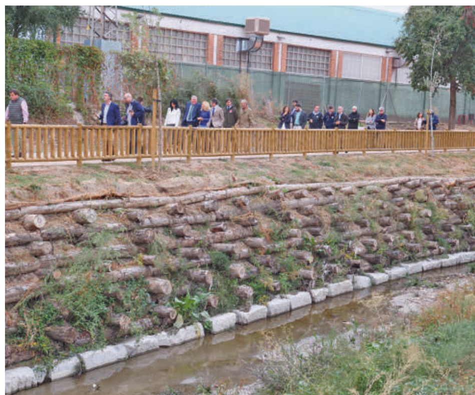
Se ha recuperado el cauce del arroyo AYUNTAMIENTO DE ALCOBENDAS
