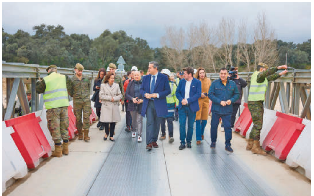
Tareas de reconstrucción de uno de los puentes
