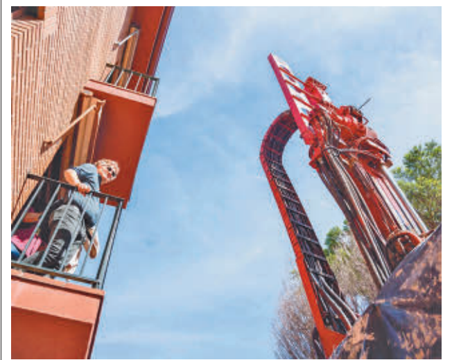
Obras por la línea 7B de Metro E.P.
