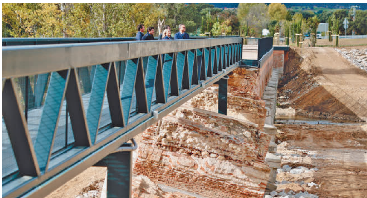
Pasarela desde la que se podrá observar el Puente de La Pedrera
