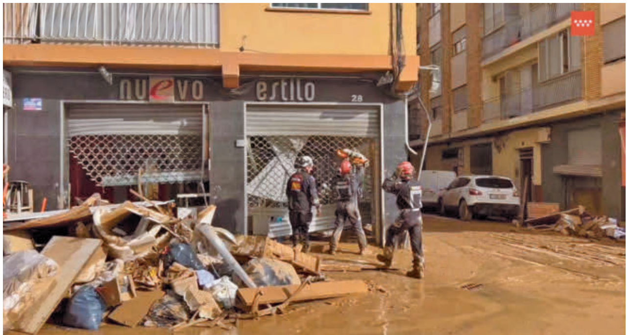
Efectivos del Ericam trabajan en la zona afectada por la DANA
