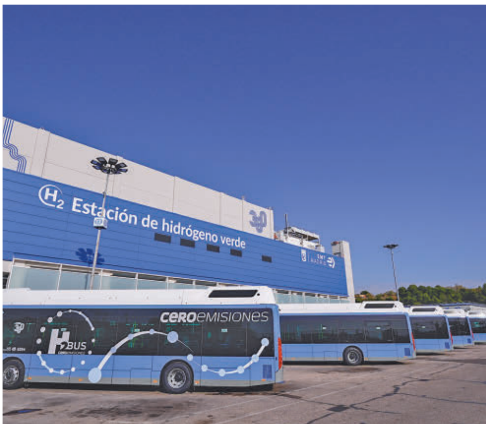
Las instalaciones situadas en el Centro de Operaciones de EMT Madrid
