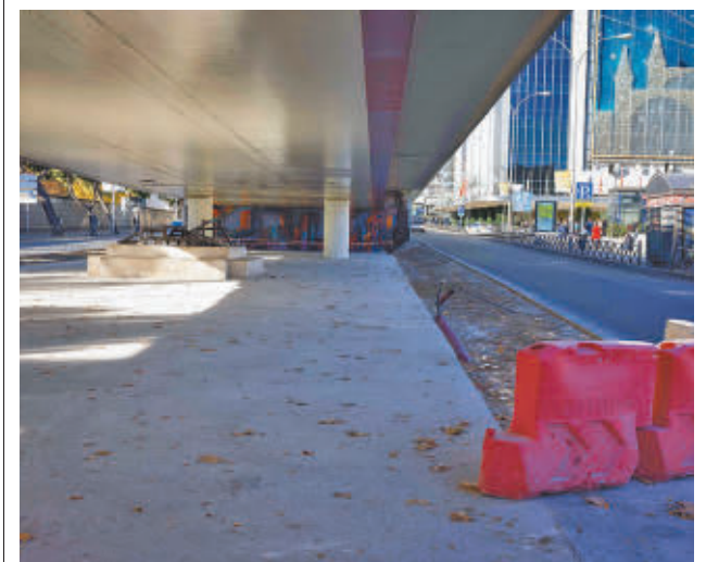
Estado actual de las obras de remodelación
