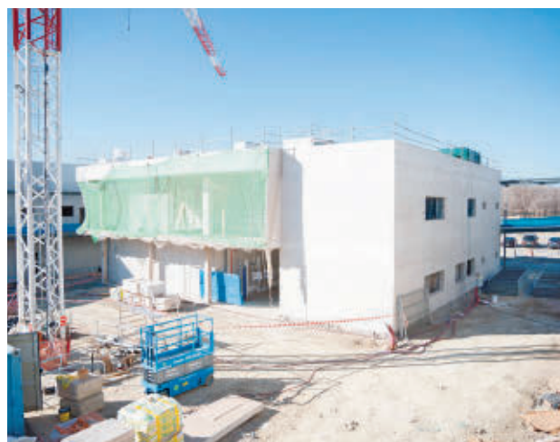
Las obras de construcción del polígono, en Villa de Vallecas
