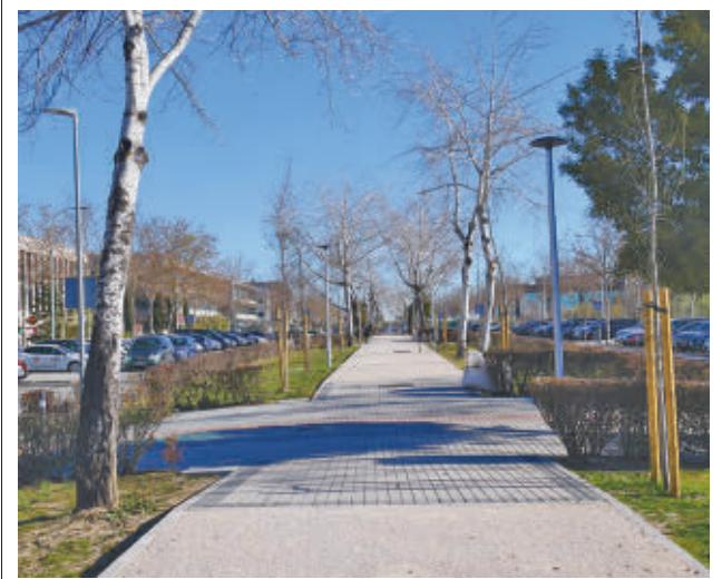
Estado actual de la zona, tras la finalización de las obras
