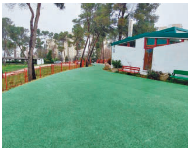
Los nuevos pavimentos exteriores del colegio
