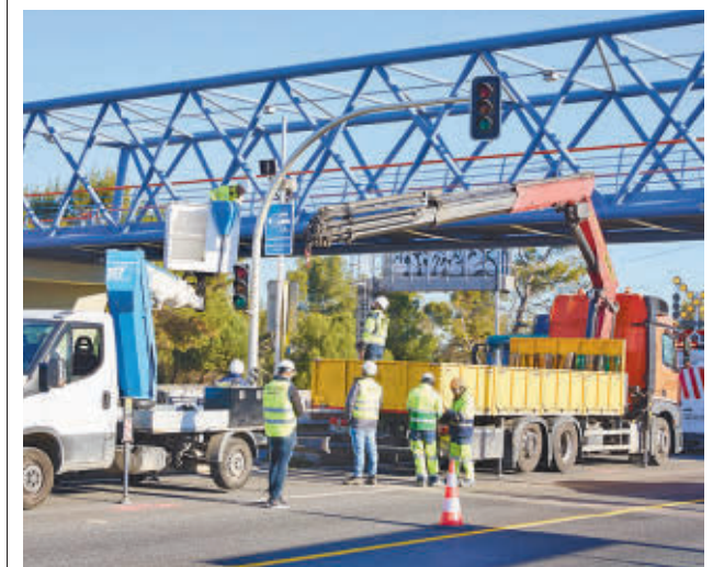
Trabajadores desmontaron el radar de tramo existente
