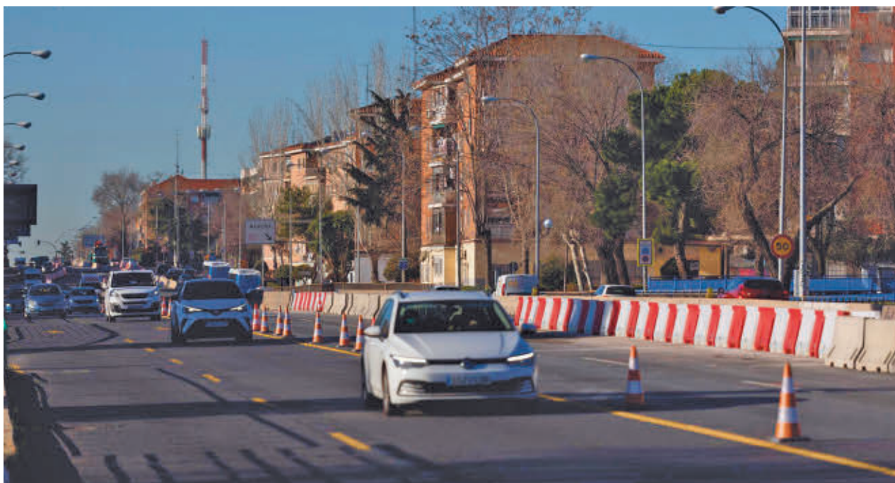
Varios coches circulan por el tramo de obras
