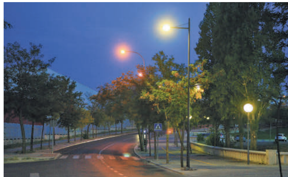
Las nuevas luminarias suponen una importante reducción de potencia
