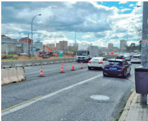
Las obras de soterramiento de la A-5 @SEGUIMOSOBRA5
