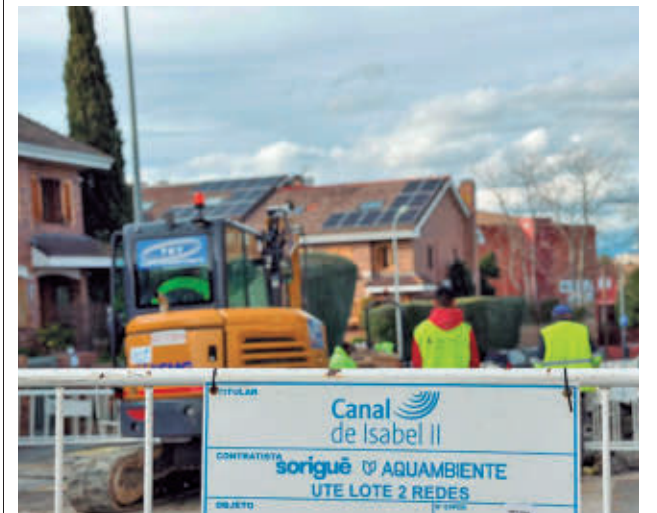
Las obras del Canal de Isabel II
