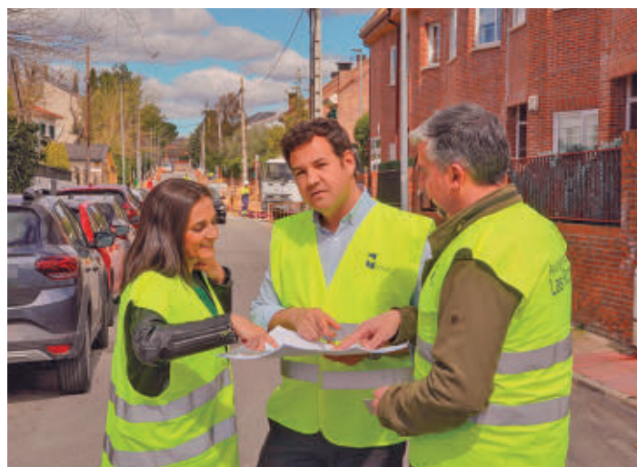
También en viviendas: El proyecto de soterramiento incluye los trabajos de 61 actuaciones en viviendas particulares, donde se ha realizado el enterramiento de cables de acometida, contribuyendo así a eliminar los cables aéreos que afectaban a la estética y funcionalidad del entorno.
