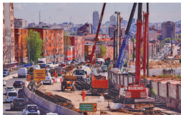
Las obras de soterramiento de la A-5
