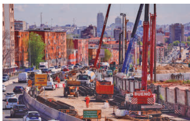
Las obras de soterramiento de la A-5
