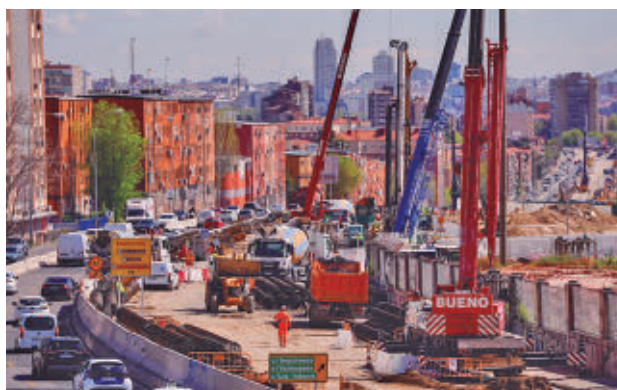
Las obras de soterramiento de la A-5
