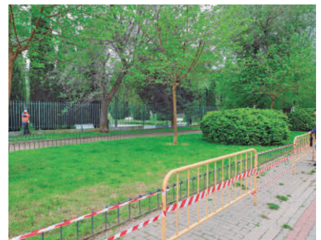
Obras en el Parque de Sementales
