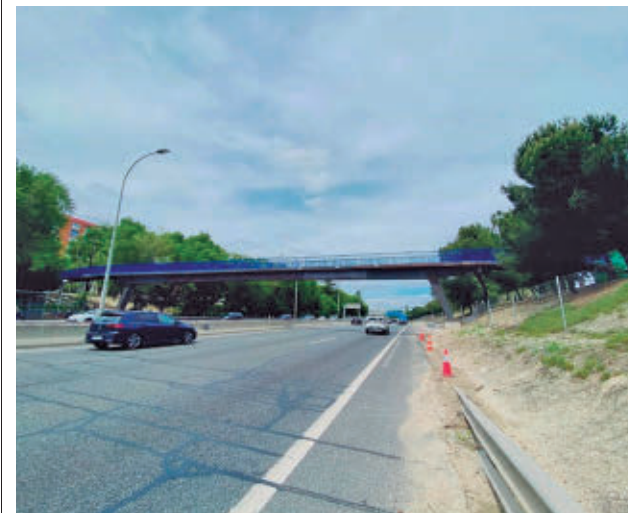
La nueva pasarela peatonal sobre la A-3
