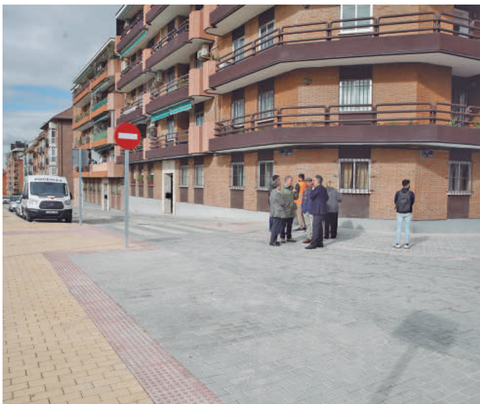
Uno de los espacios remodelados en el cruce de las calles de Gutiérrez Sañudo y Peña Labra
