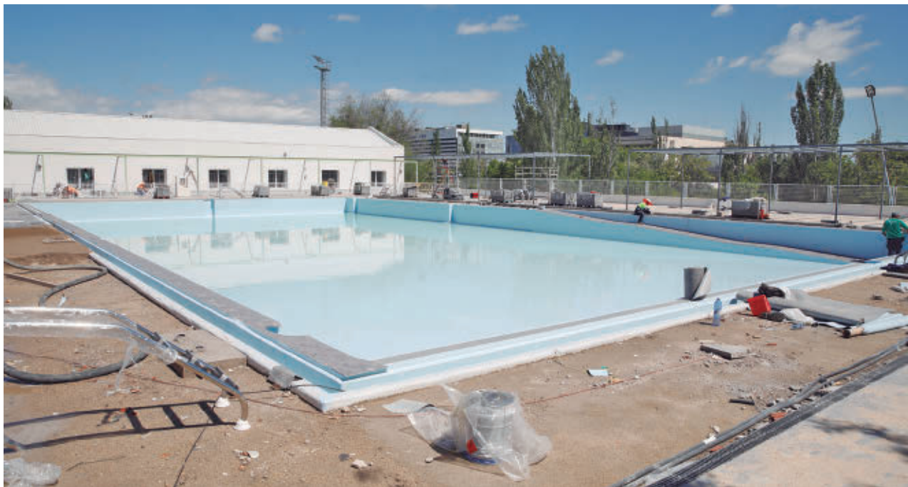
Las obras que se están llevando a cabo en uno de los vasos de las instalaciones del Luis Aragonés
