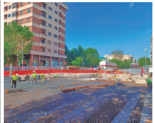
Las obras de ampliación de la L11 en Palos de la Frontera
