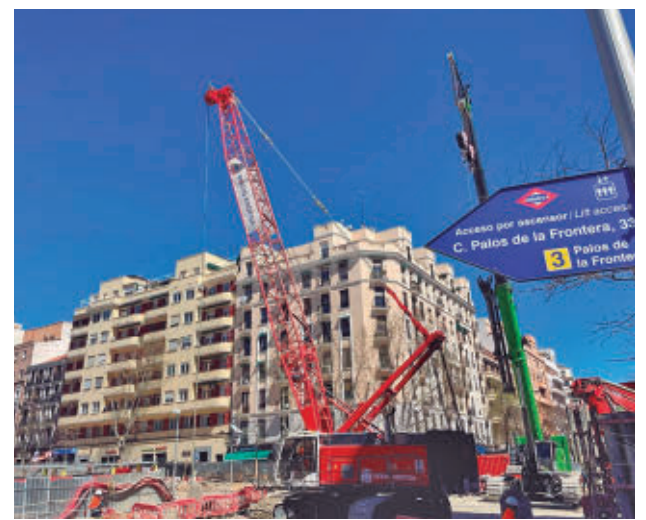
Las obras de ampliación del suburbano
