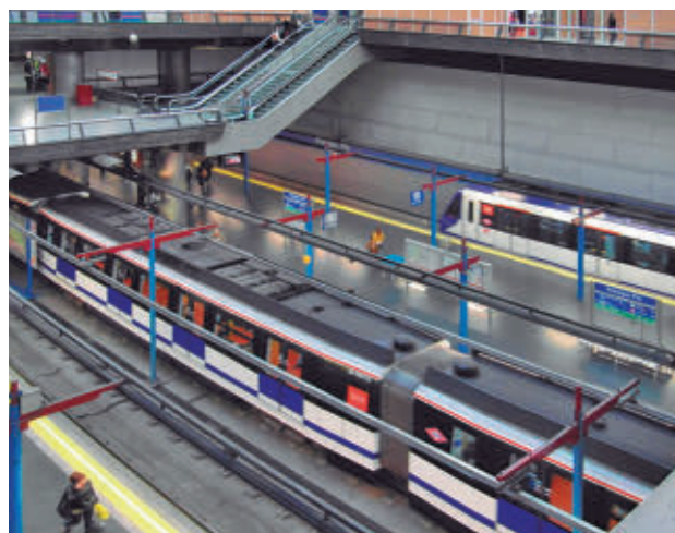
Estación de Príncipe Pío, en la Línea 6
