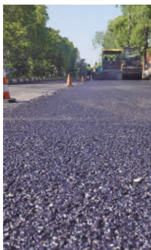
Labores de asfaltado
