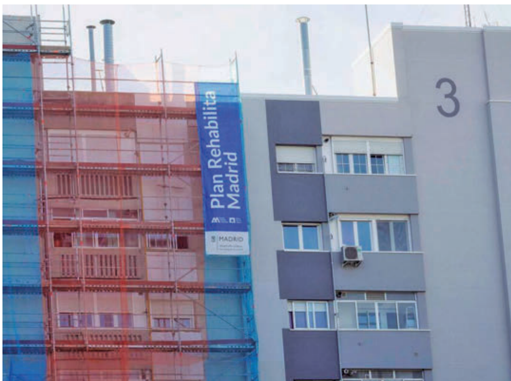
Obras de rehabilitación en uno de los edificios del Poblado Dirigido de Orcasitas FRAVM
