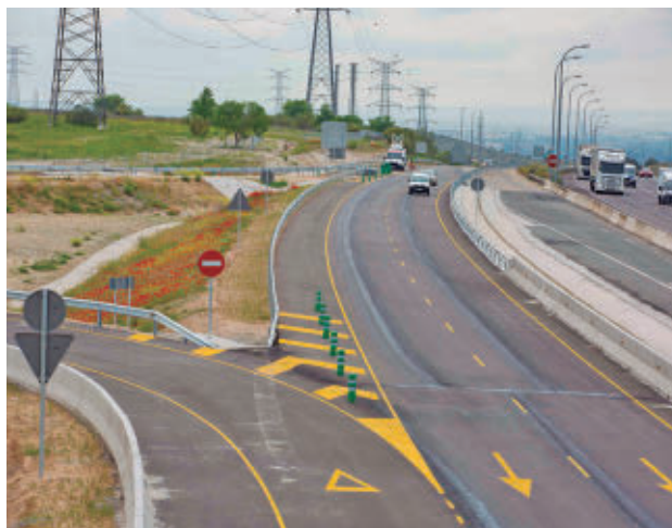
Nuevo enlace de la M-50 en Rivas
