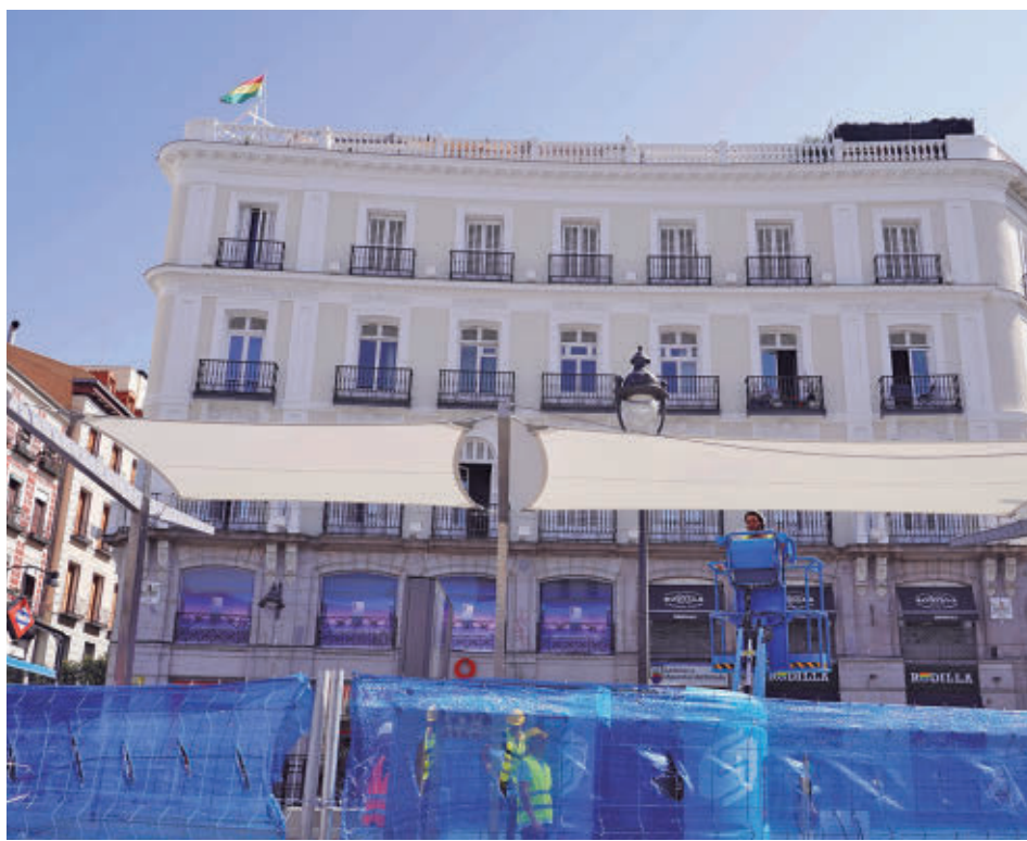
Trabajadores ultiman el proceso de colocación de los nuevos elementos
