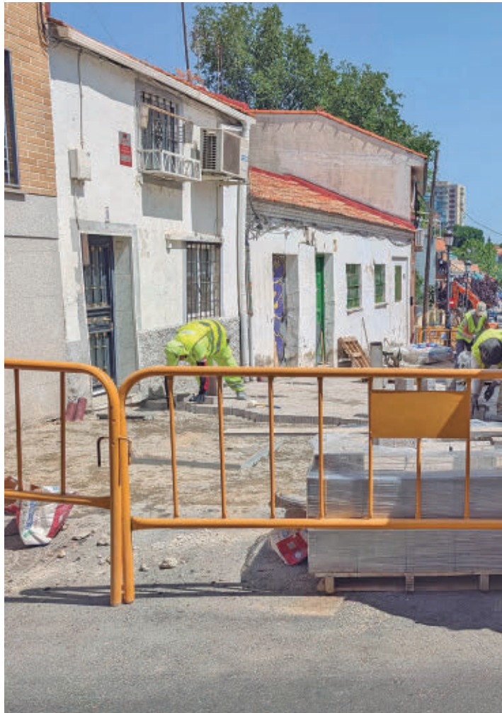
Los trabajos en una de las calles del casco histórico
