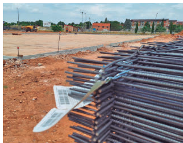
Estado actual de las obras
