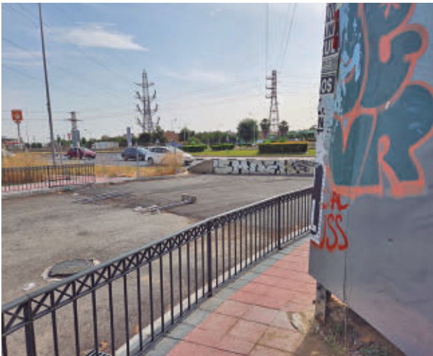
Vista del tramo de la M-406 AYTO DE GETAFE
