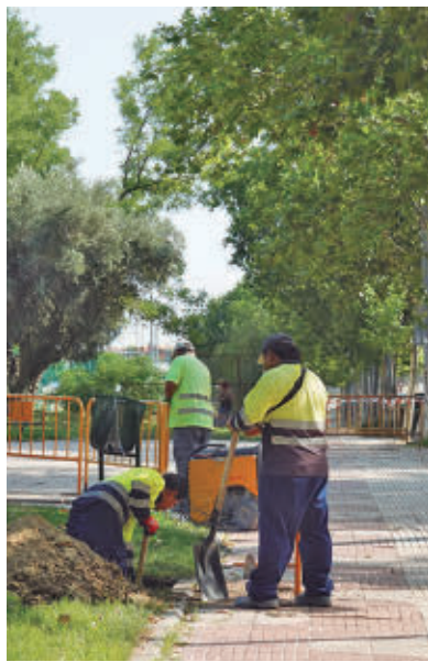
Obras en la calle Robles
