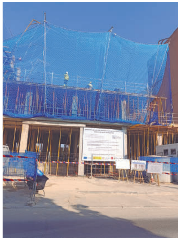
Se prevé que las obras terminen en un año
