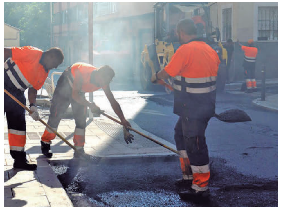
Las obras supondrán la renovación del firme en más de 142.000 metros cuadrados
