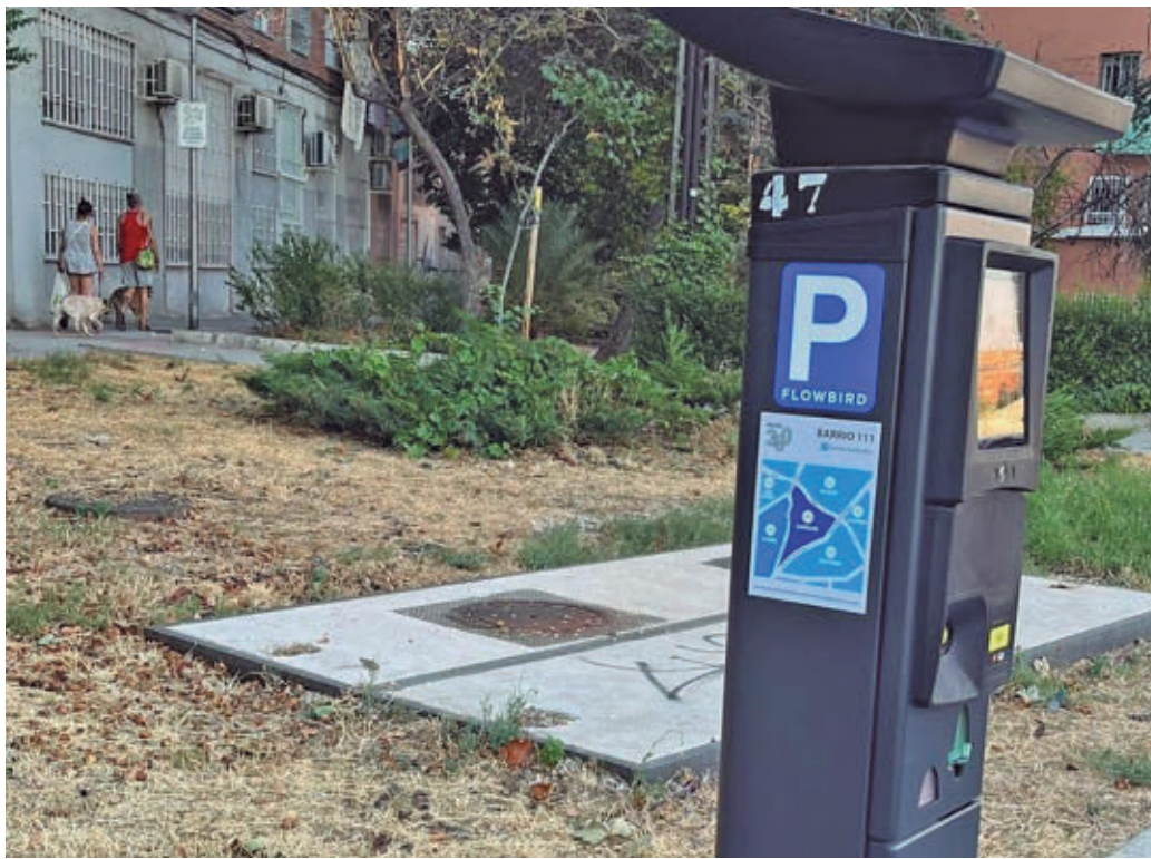
Uno de los nuevos parquímetros instalados en Carabanchel @MADRESTRESADAS
