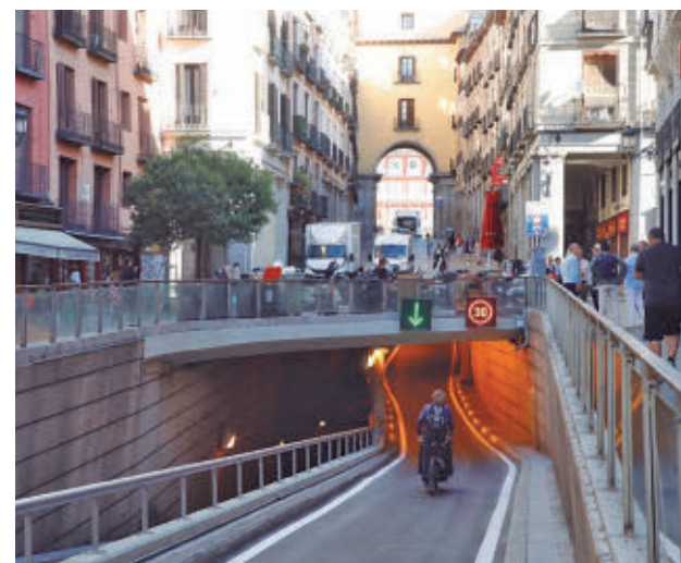
Estado actual del paso subterráneo
