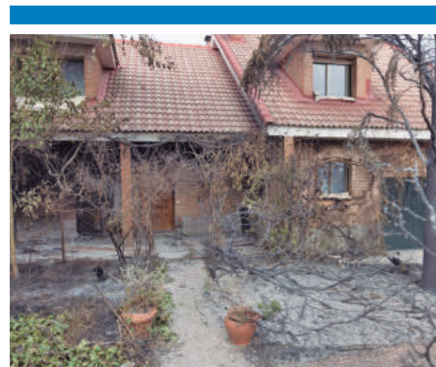
Una de las viviendas afectadas AYTO DE TRES CANTOS
