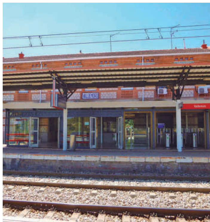
Estación de Cercanías de Valdemoro
