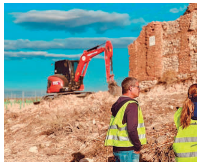
Obras en la Ermita de Vilches
