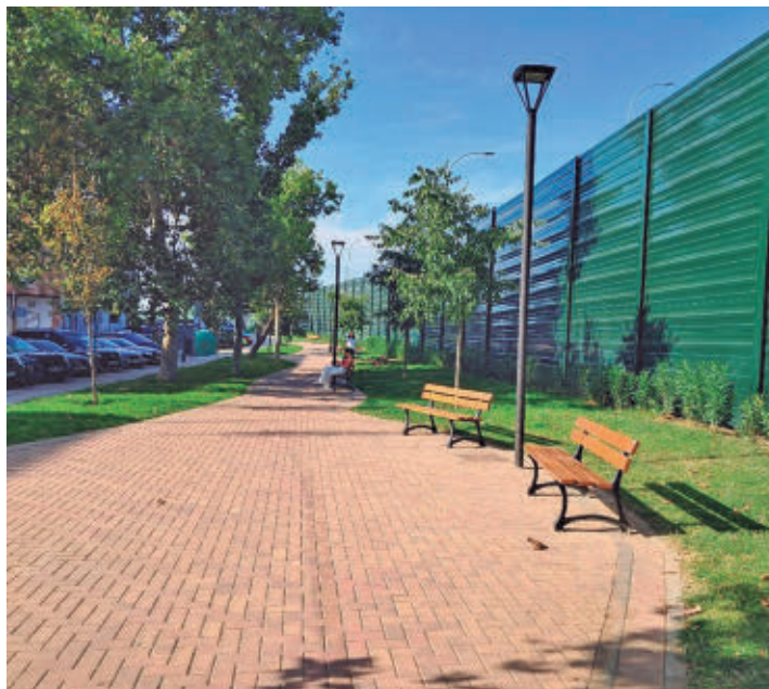
Pantallas acústicas para reducir el ruido de la A-42 M. DE TRANSPORTES
