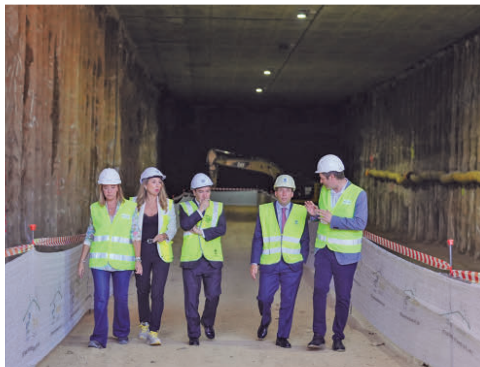
Un momento de la visita del alcalde a los trabajos de soterramiento de la A-5
