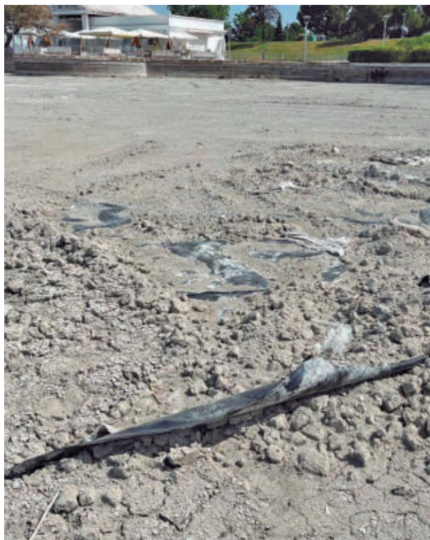
Estado actual del lago del parque Juan Carlos I
