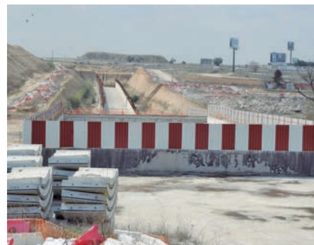
Obras de ampliación de Cercanías a Navalcarnero E.P.
