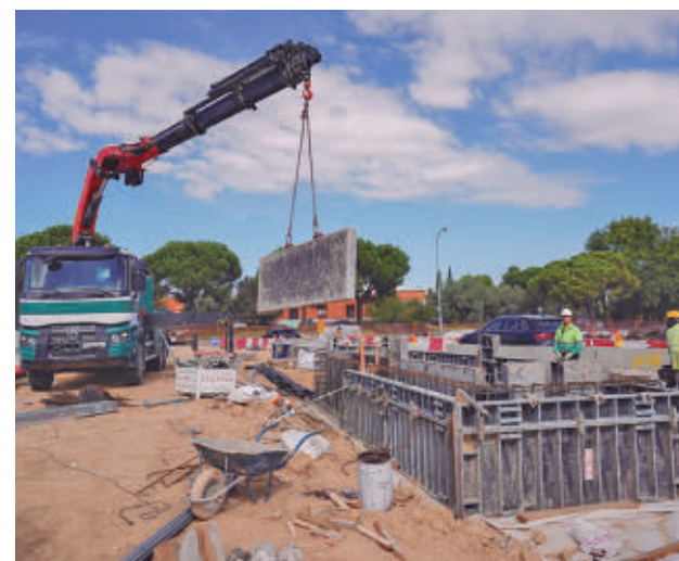
Los trabajos de ejecución del Paseo Verde del Suroeste
