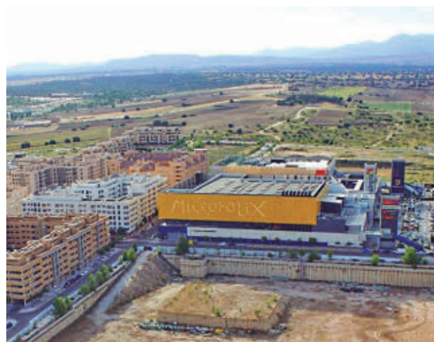
Vista aérea del lugar donde se ubicará este desarrollo
