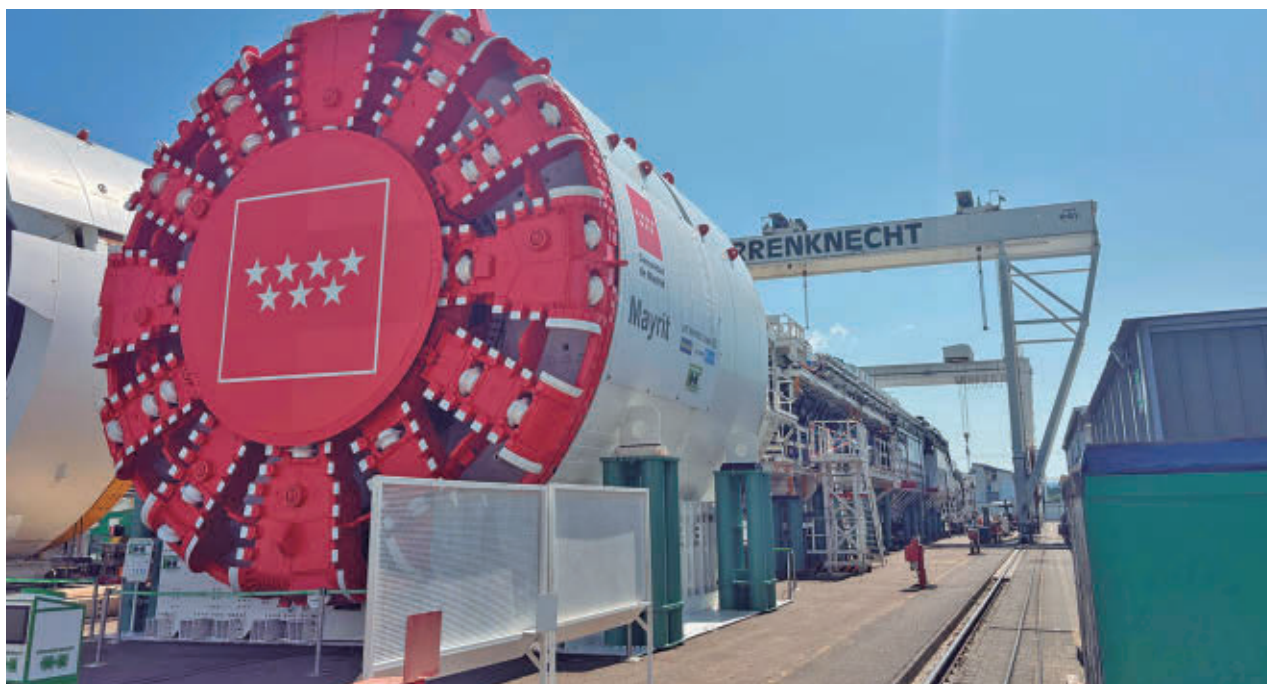
La tuneladora 'Mayrit', durante su construcción en Alemania
