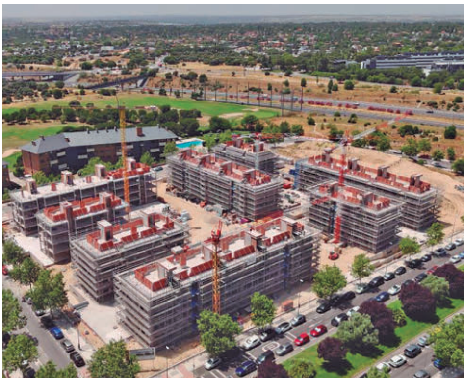
Una imagen área de las promociones en construcción
