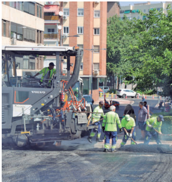
Trabajos en el asfaltado llevados a cabo este verano
